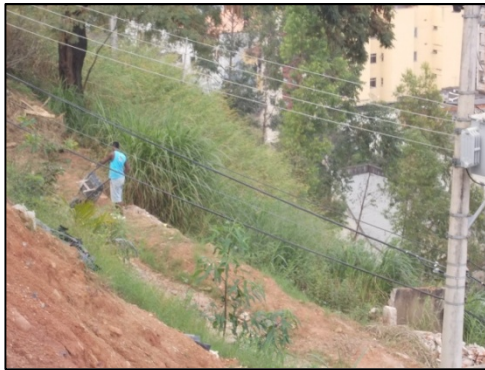
Ponto 05 (Lançamento de lixo e entulho no topo do talude).
