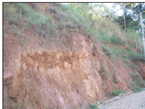
Ponto 97 (Talude de corte com solo residual jovem exposto).
