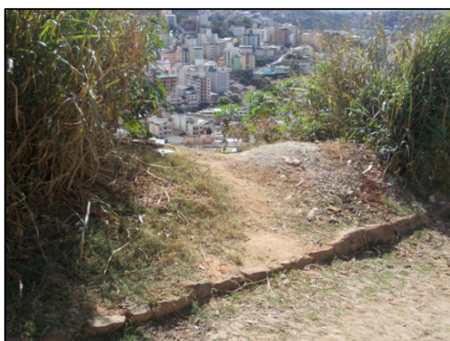
Ponto 12 (Lançamento de lixo e entulho no topo do talude).
