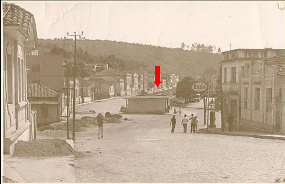
Figura 2 – Antiga Rodoviária de Viçosa (fonte: Google)
